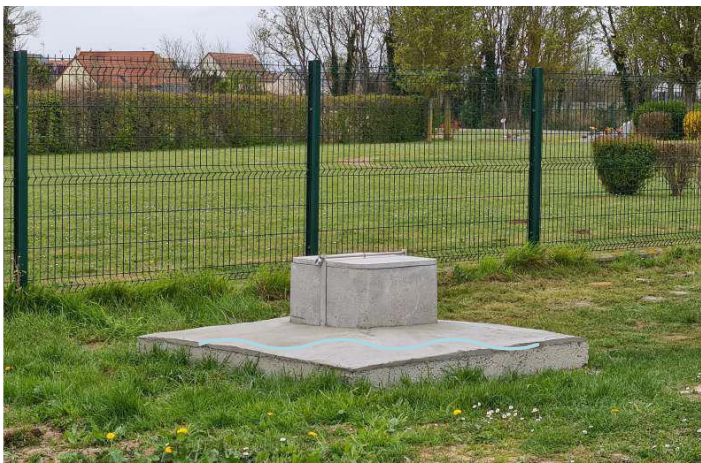
Exemple d'un forage protégé - EBC
