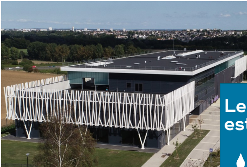
Usine de la prise d'eau de l'Orne
